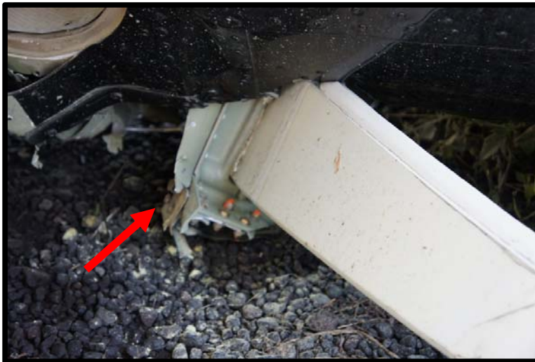
Fotografía No. 6 Soporte del tren principal izquierdo quebrado.
